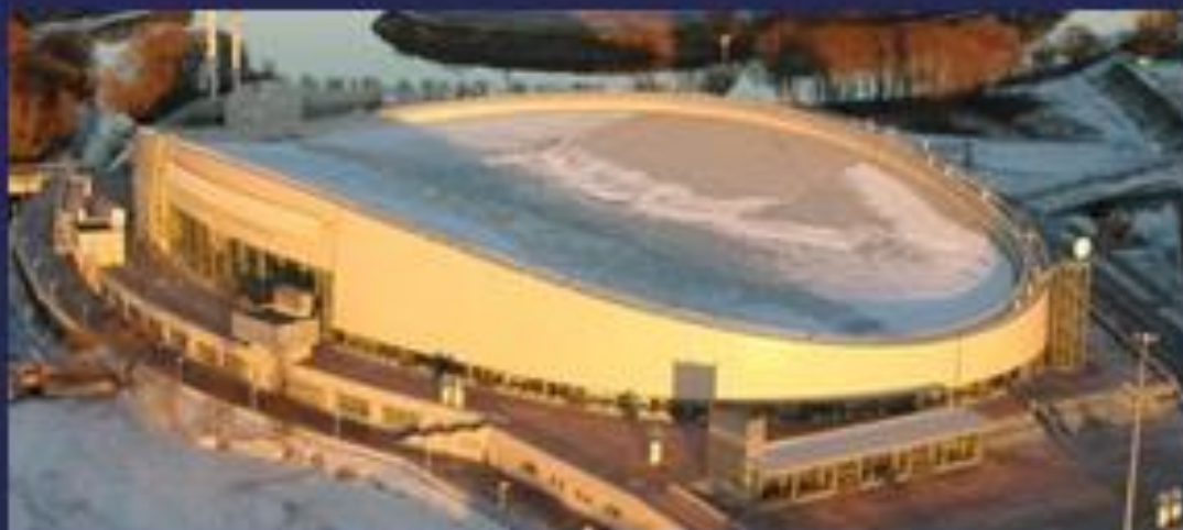
КОНЬКОБЕЖНЫЙ ЦЕНТР В КОЛОМНЕ. Покрытие (200x110 м) седловидная стальная мембрана ( t=4 мм)
