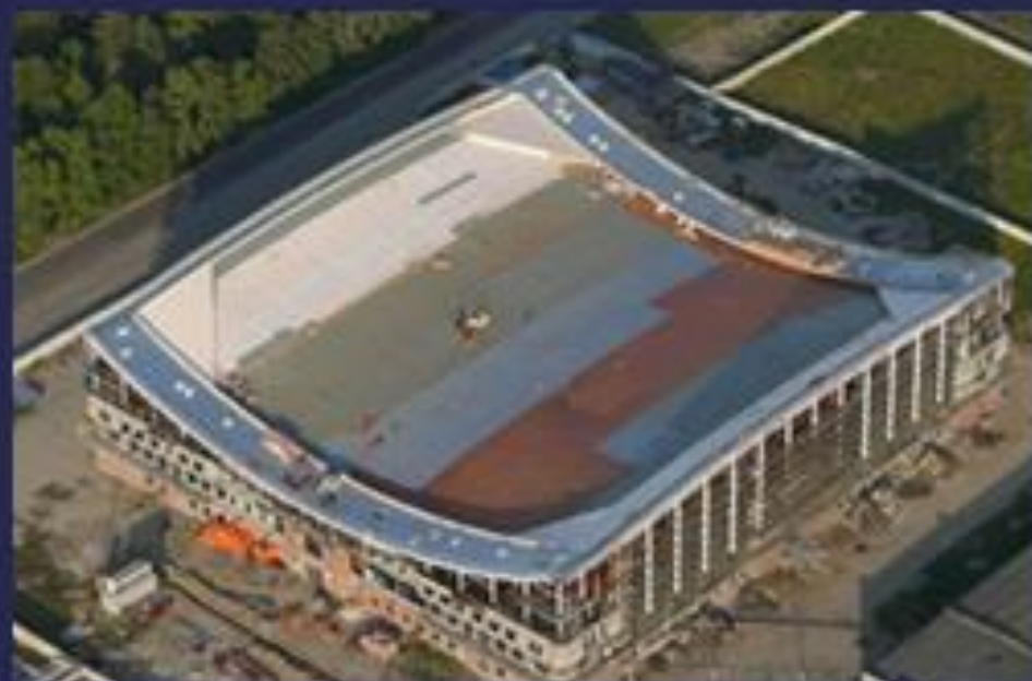
КОНЬКОБЕЖНЫЙ ЦЕНТР В КОЛОМНЕ. Покрытие (200x110 м) седловидная стальная мембрана ( t=4 мм)
